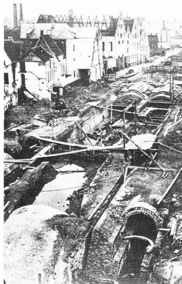
*Photo prise en 1870 montrant la grande percée ouverte dans la vieille ville pour le voûtement de la Senne. Les deux grandes arches en arc de cercle du voûtement sont flanquées chacune d'un égout collecteur destiné à recevoir les eaux usées. La vue a été prise à la hauteur de la rue des Teinturiers en direction du temple des Augustins (qui fut remplacé par la place de Brouckère).*
